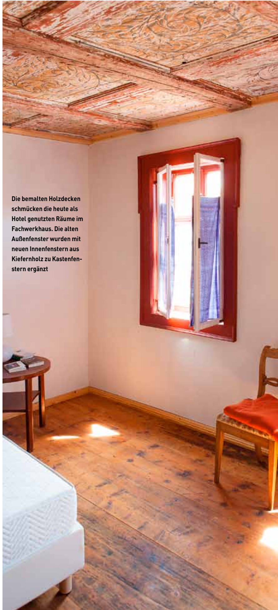
Bemalte Holzdecken waren unter Sauerkrautplatten versteckt
