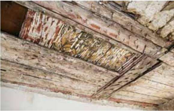
Bemalte Holzdecken waren unter Sauerkrautplatten versteckt
