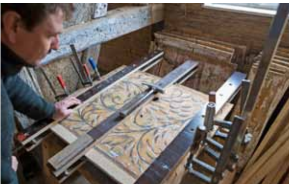
Die historischen Holzdecken wurden vor Ort repariert
