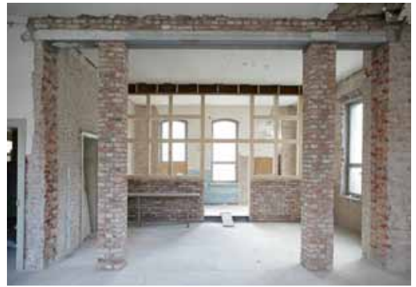
Die Trennwand, die vor Umbau den ersten Stock der Fabrik verschloss, ersetzen die Maurer durch zwei Backsteinsäulen
